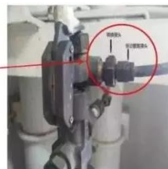
图4 增压阀连接气动管路局部
