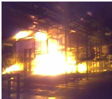
图1. 雷击后燃烧的贮罐
