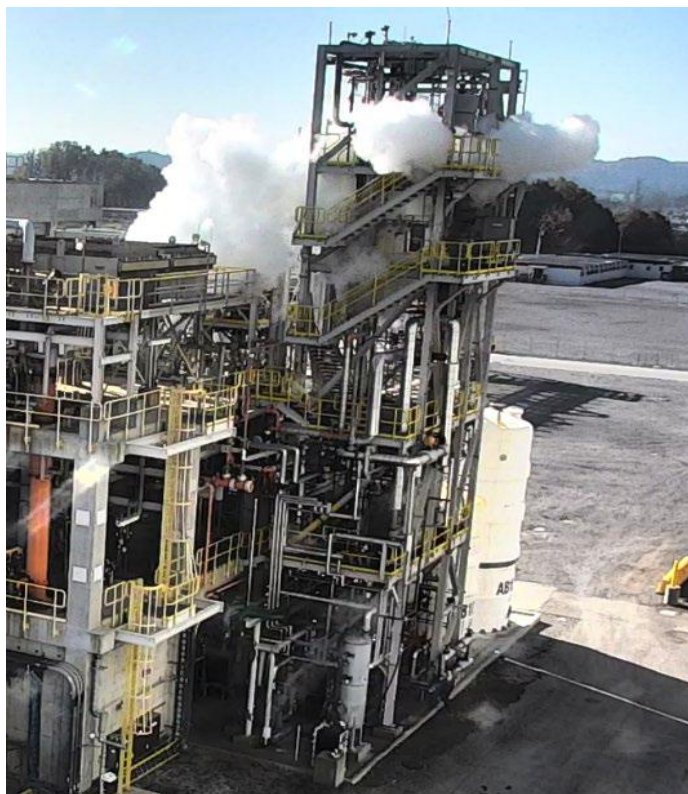
图1. 发生泄漏的平台。十五秒后，整个平台就被烟雾吞没。（参见CSB 报告编号 2021-01-I-TN）
