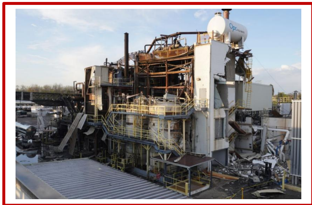
图1. 树脂生产装置内部爆炸后的图片 (来源：CSB报告 No.2021-04-I-OH)
