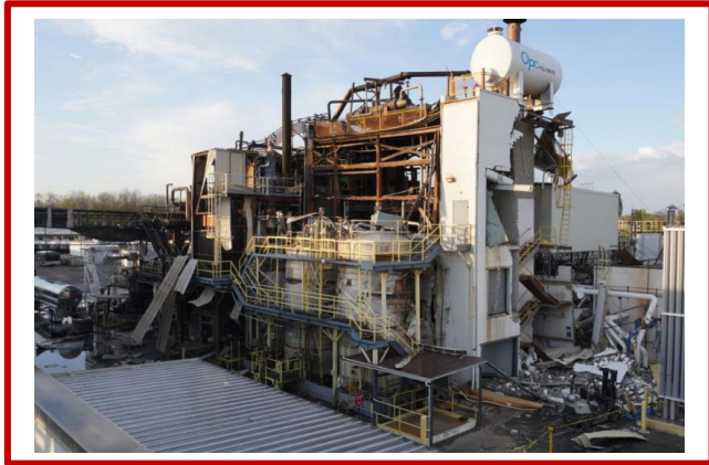
תמונה 1 . מבנה ייצור השרף לאחר הפיצוץ מקור : (CSB report No. 2021-04-I-OH)
